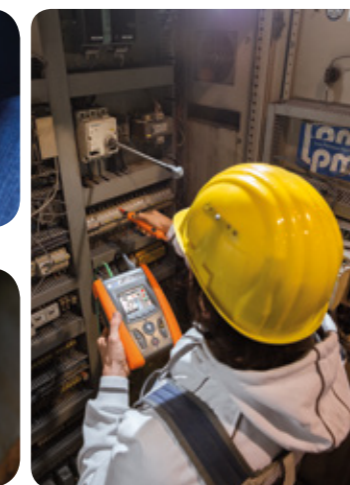
Start/stop misura con puntale remoto PR400.
