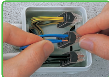
Conexão: Insira o condutor rígido totalmente descarnado!
