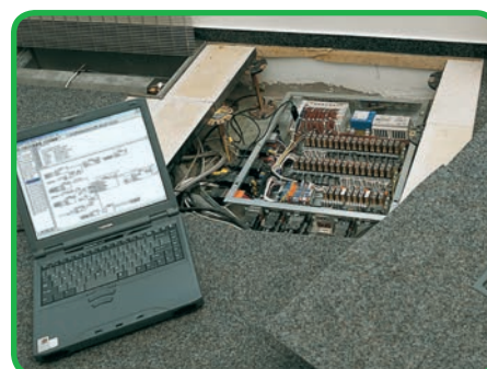
Caixas de distribuição subterrâneas
