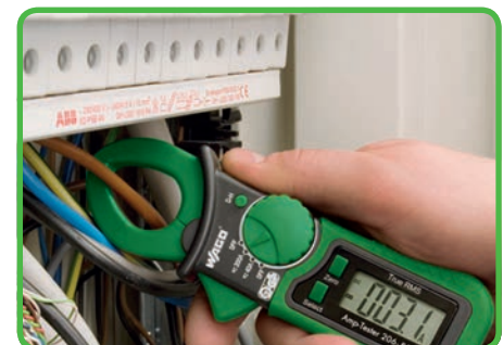
Medição de corrente no armário de distribuição.
