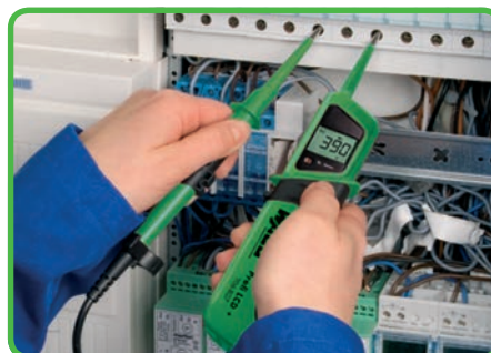
Testes de tensão no armário de distribuição.
