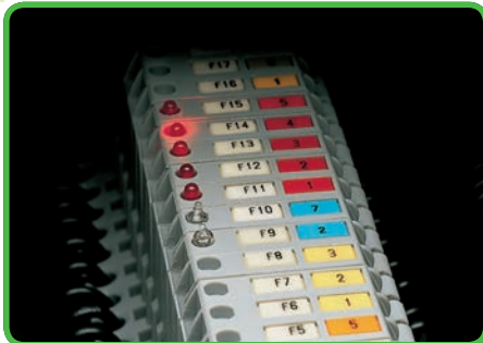
Indicador do estado do fusível por LED ou lâmpada de néon.
