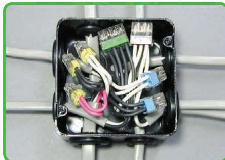
Conectores PUSH WIRE® utilizados numa caixa de distribuição. (Japão)
