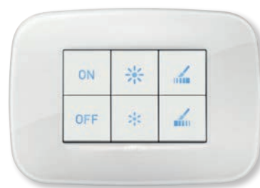
Controlos de domótica para controlo da iluminação
