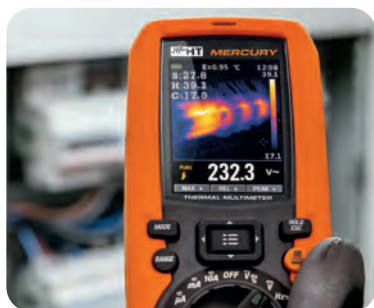
Análise Termográfica do Quadro Elétrico.
