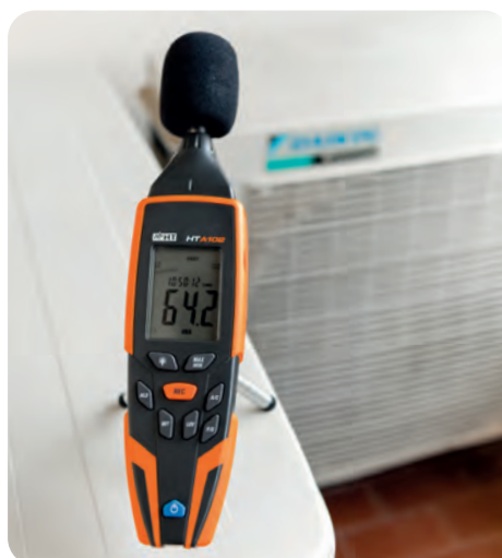
Medição de ruído de uma bomba de calor com HTA102
