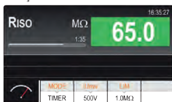
Medição da resistência de isolamento
