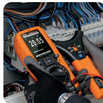
Medição de Correntes AC.
