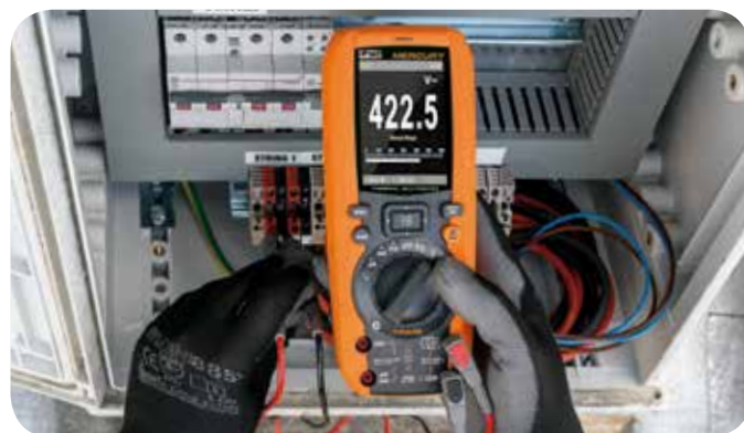
String FV: Medição de Vmpp.
