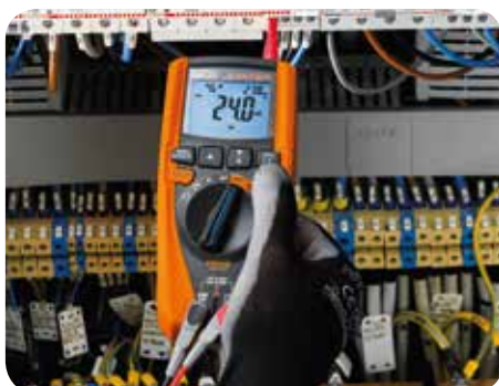
Verificação do tempo e corrente de disparo do RCD.
