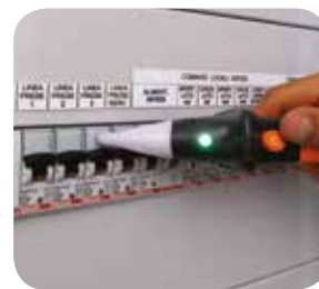
Identificação do interruptor com proteção da linha.
