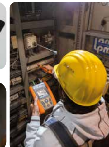
Start/stop misura con puntale remoto PR400.
