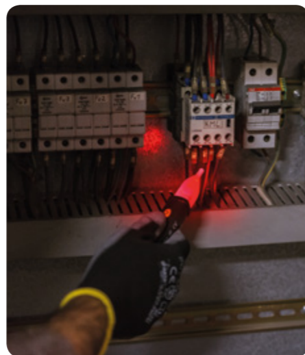
Rilevazione di tensione AC sulla guaina di protezione del cavo.
