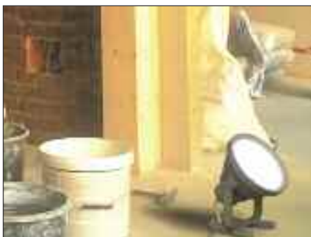
Faro da cantiere
